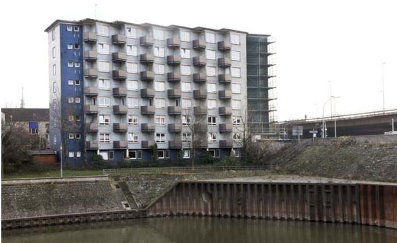
Foto 3: Mündung des Dickelsbaches (Loch in der Spundwand) in den Außenhafen (Foto: Sonja Krischbach). Eine zweite Mündung entwässert in den Kultushafen.
