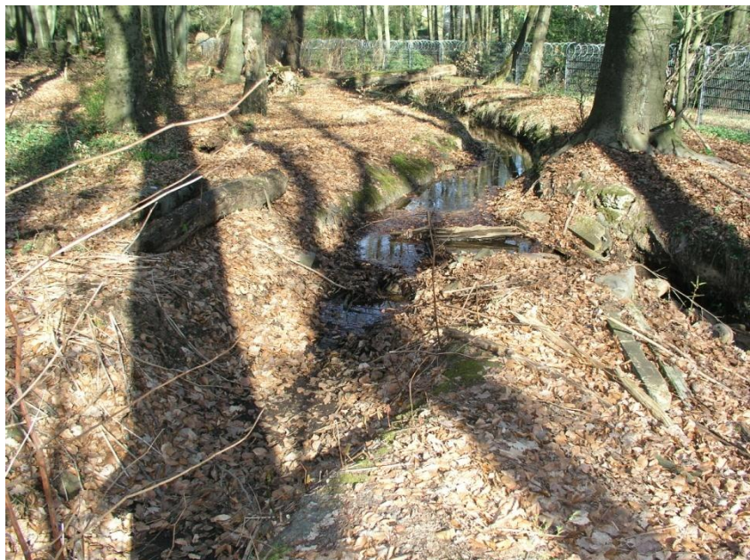
Abbildung 4.78: Ausleitung aus dem Schengerholzbach in die Überleitung in den Wambach
