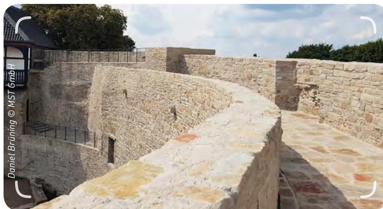
Wie erfolgreich die Erneuerung von Stein, Mörtel und Mauerschale von den beiden Baufirmen TORKRET GmbH und Pressbau Erfurt GmbH umgesetzt wurde, kann nun wieder selbst erfahren werden: Der 7,45 Meter hohe
