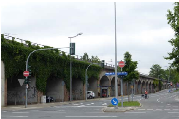
Abb. 5: Viadukte des neuen „Radwegs Rheinische Bahn“ [Quelle: Eigene Aufnahme]
