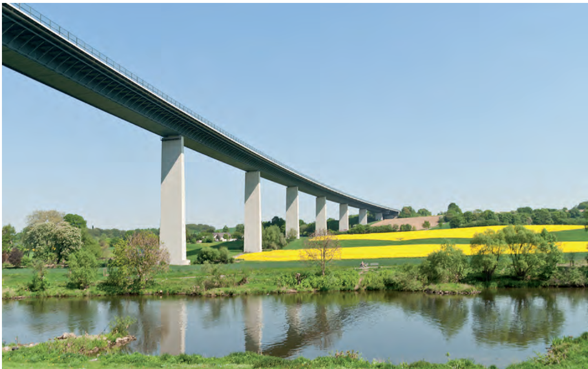
Abb. 51 Blick auf die Ruhrtalbrücke (Quelle: medl GmbH)
