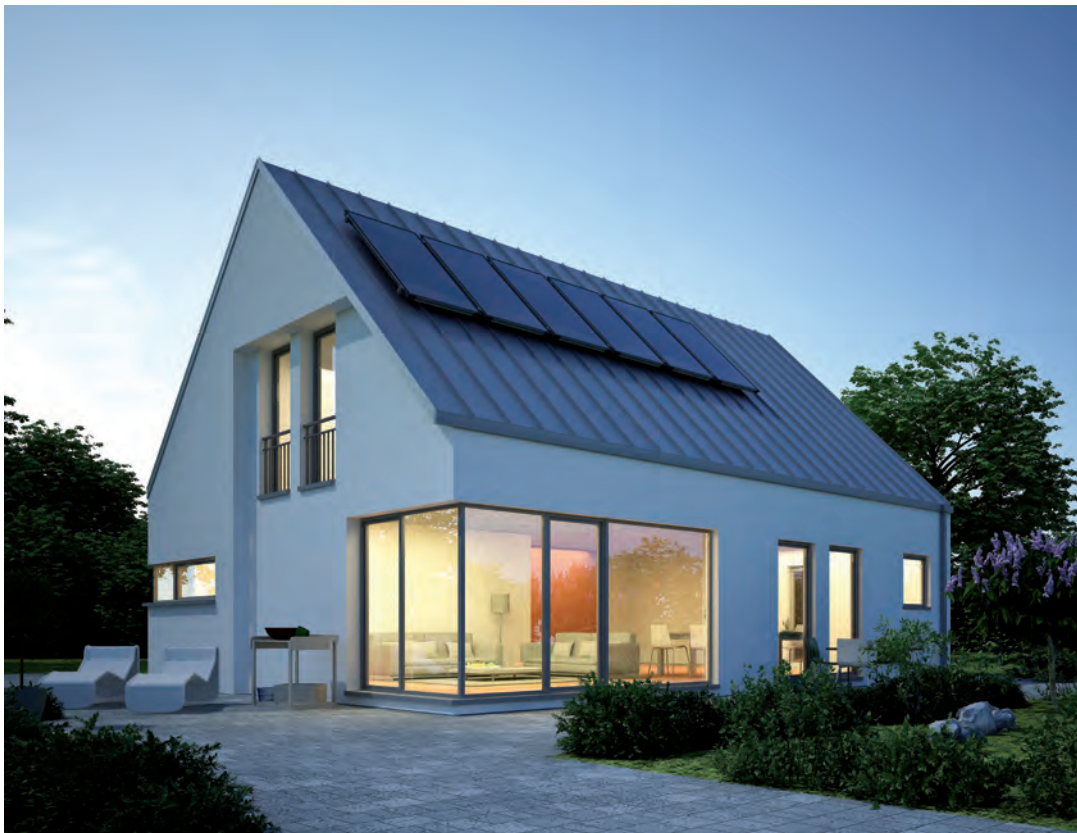
Abb. 65 Energieeffizientes Gebäude (Quelle: medl GmbH)
