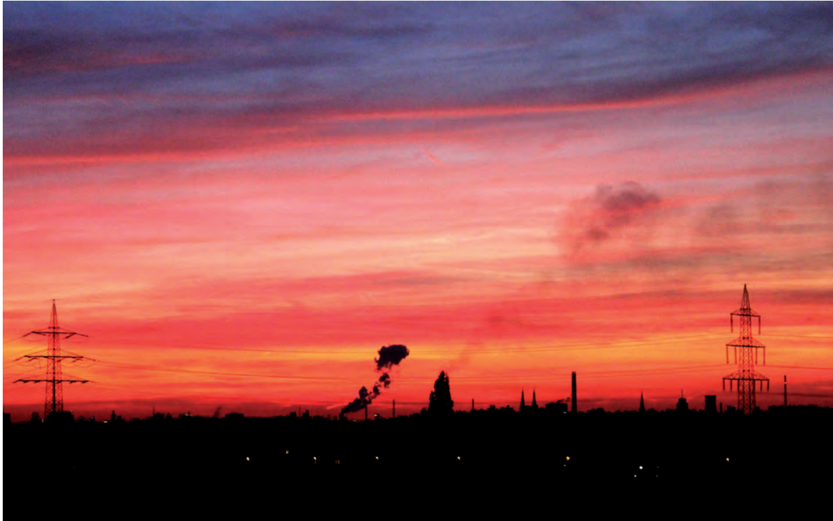
Abb. 3 Energieversorgung: rund um die Uhr (Quelle: medl GmbH)
