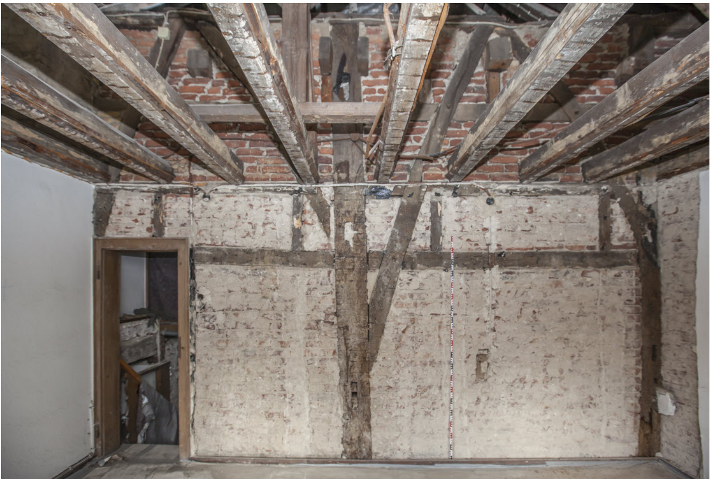
Abb. 16/17 Geschossständerkonstruktion der östlichen Traufseite mit Zapfenschlossern der Bundbalken und Kopfstreben im Bereich 105d (oben) und 104a (unten) Fotos: ASE
