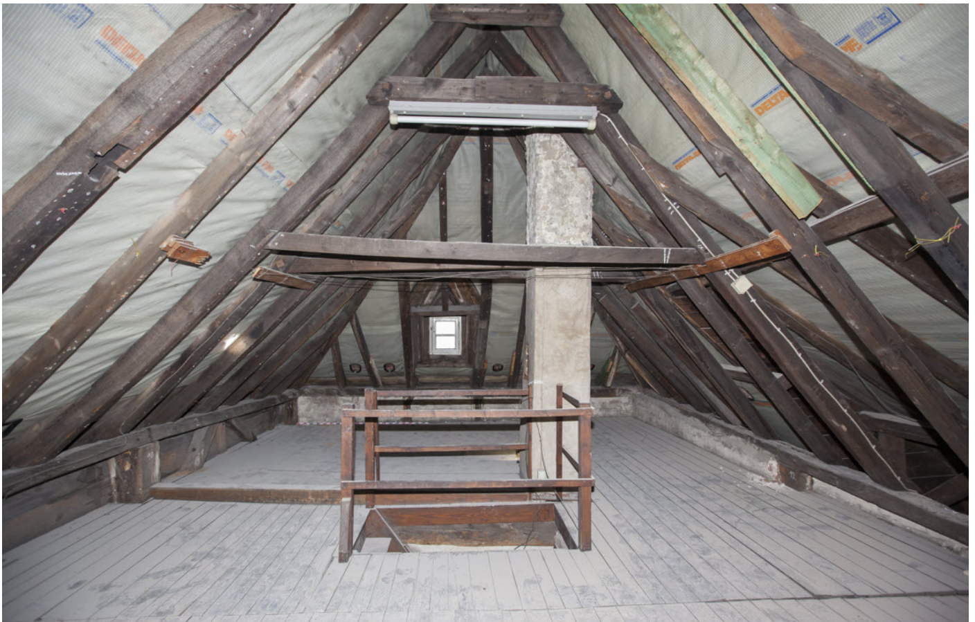
Abb. 26 Dachraum mit Dachwerk und Kniestock, Blick nach Norden. Gut erkennbar die Rähme und Ständer sowie Kopfstreben. Fotos: ASE
