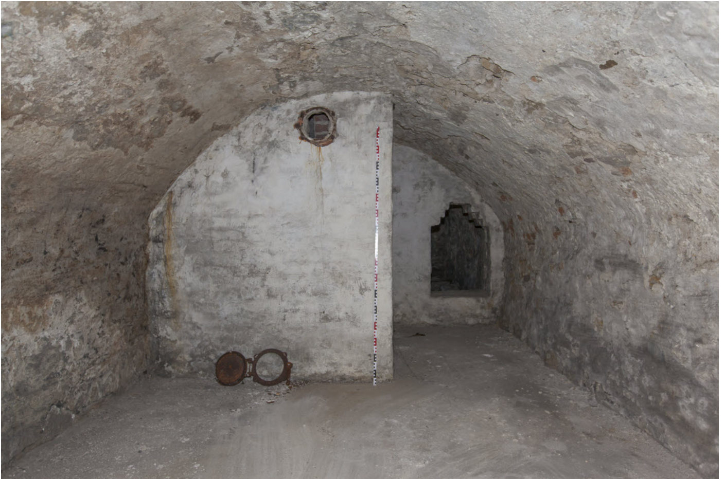
Abb. 34-35 Gewölbekeller unter der Abseite mit nachträglicher Teilung und Nutzung als Luftschutzkeller; unten: südliche Stirnmauer Fotos: ASE
