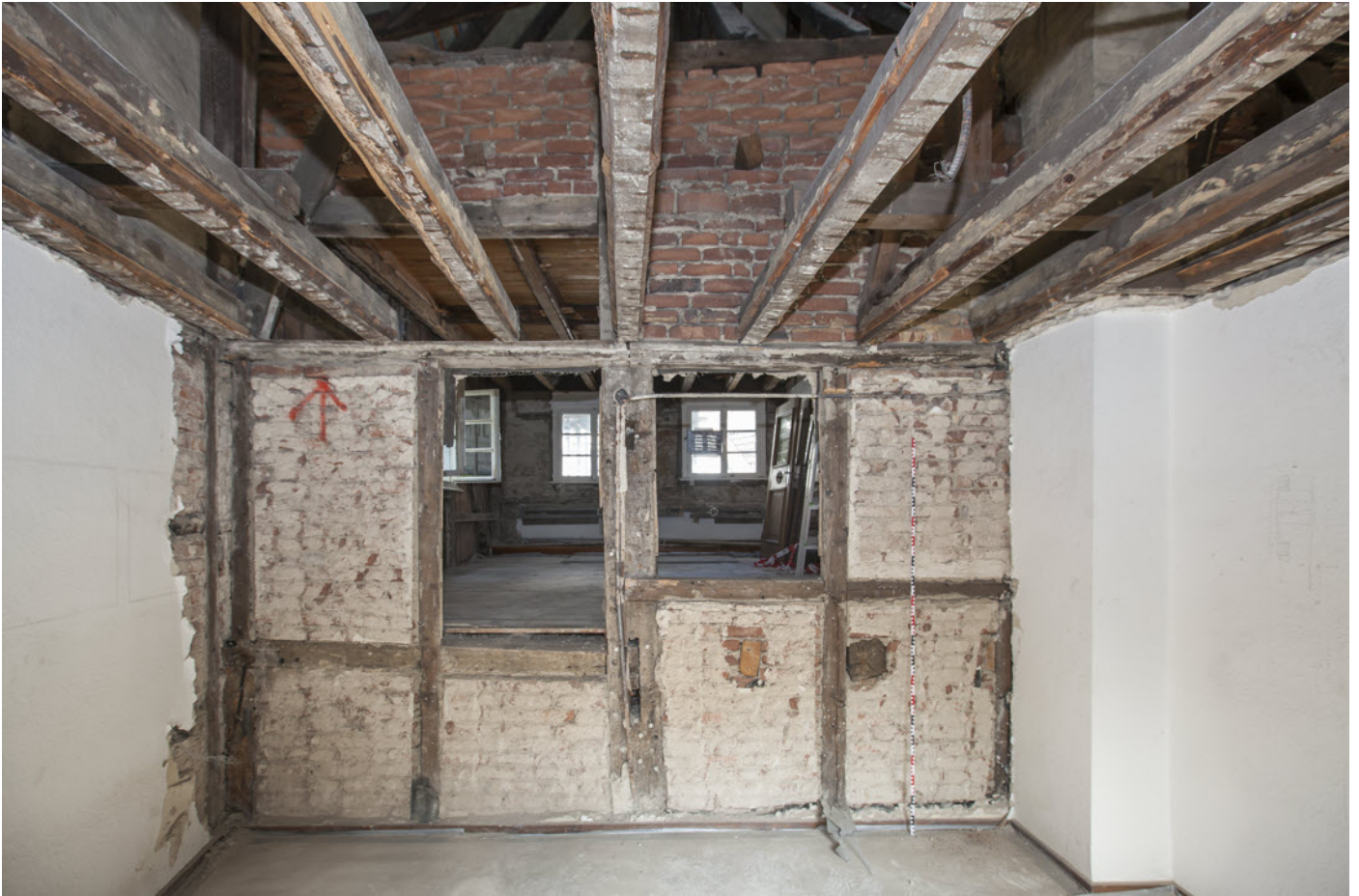
Abb. 16/17 Geschossständerkonstruktion der östlichen Traufseite mit Zapfenschlossern der Bundbalken und Kopfstreben im Bereich 105d (oben) und 104a (unten) Fotos: ASE
