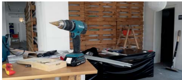
Zuerst galt es, den Sperrmüll loszuwerden und die Elektrik zu erneuern.
