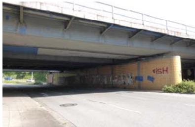
Abb 20: Unterquerung ist mit Steinzeug-Fliese verkleidet
