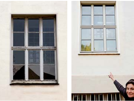
FENSTERMODERNISIERUNG AN DER GGS KLOSTERMARKT
